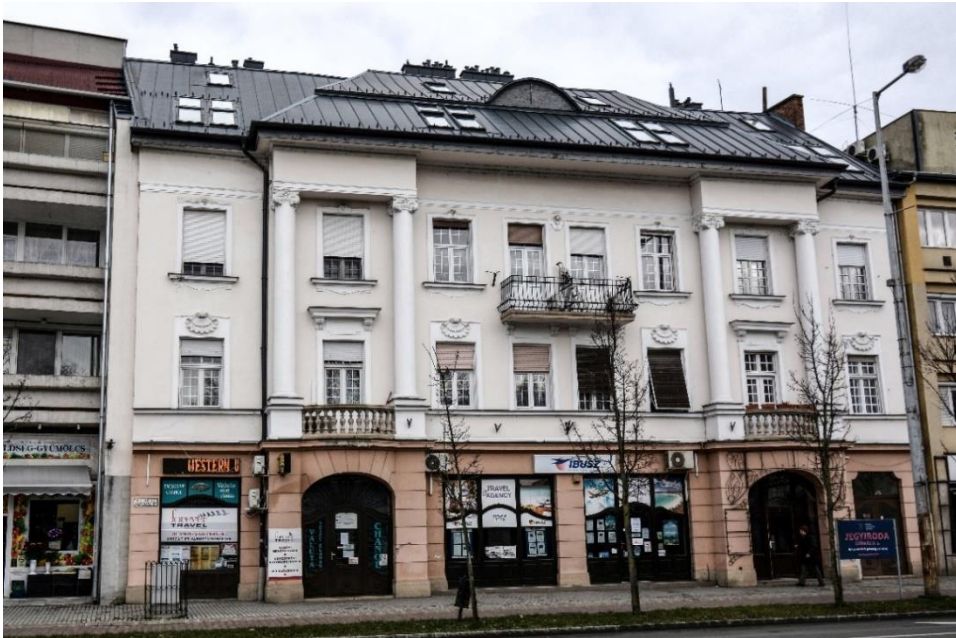
Az egykori Hitelintézet épülete ma 107
