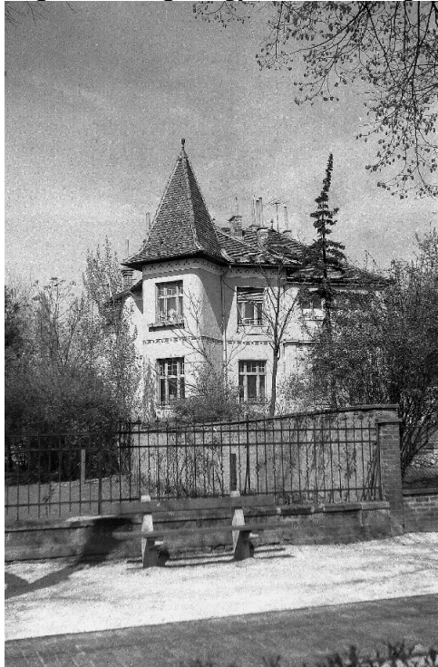
A Stegmüller-villa a tetőtér beépítése előtt 23
