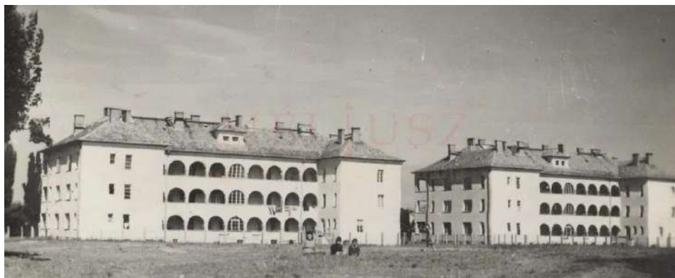
A Dobozi utca 6. és 8. számú ház udvar felőli oldala az átépítés előtt
