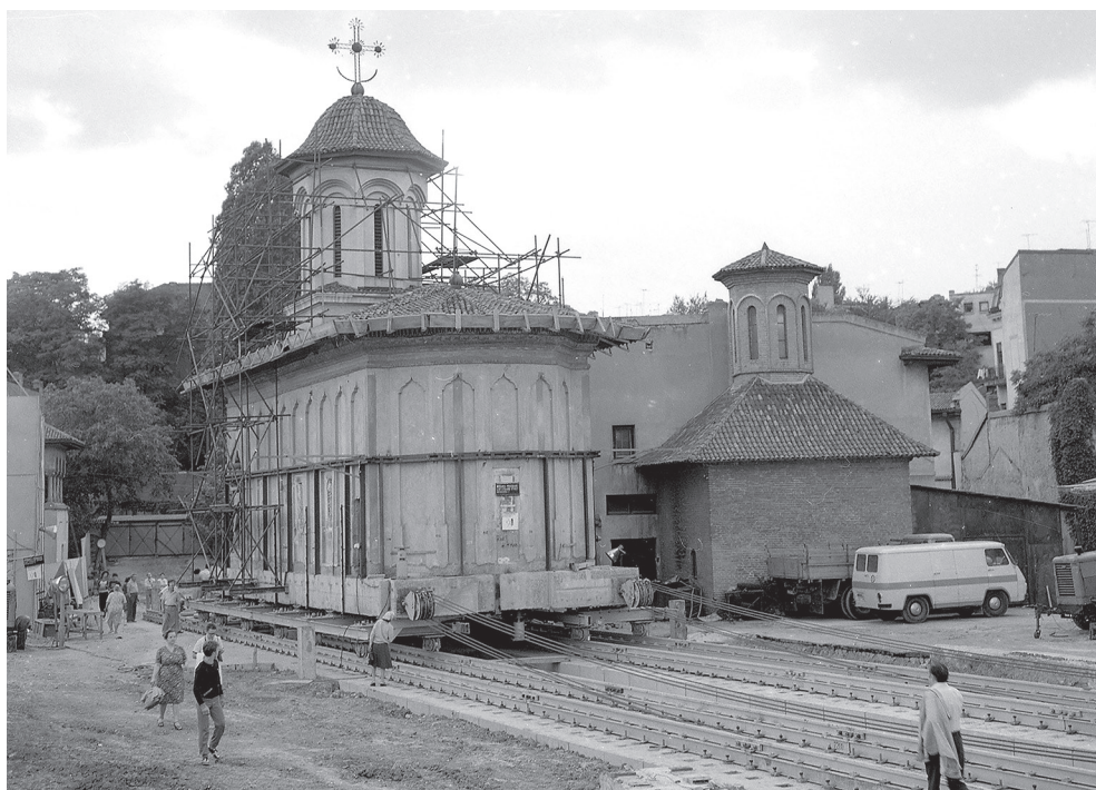
[7. kép] A bontás alatt levő Schitul Maicilor (Nővérek Remetelaka) görög-keleti kolostor Angyali üdvözllet templomának költöztetése Bukarestben, 1982-ben, az Eugeniu Iordăchescu által tervezett sínrendszeren
