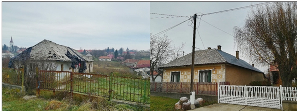
1. ábra. Egy, a katasztrófaeseményt követően elhagyottá vált ház Megyaszón ( bal ); kényszerűségből vegyes anyagokkal javított tetőzetű lakóház Megyaszón ( jobb ) Forrás: Saját felvétel
