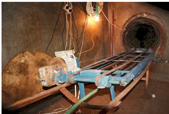
12. kép. Az alagút bejárata 15
