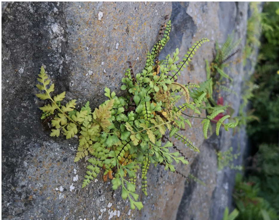
e12. ábra Gymnocarpium robertianum a felújított Salgóvár (Salgótarján) kőfalának fugájában, Cystopteris fragilis , Asplenium t. subsp. quadrivalens és A. ruta-muraria társaságában. Ilyen kis térléptékben (5 cm) négy különböző, mészkedvelő páfrányfaj közös előfordulása, különösen bazaltkúpokon, közép-európai szinten is ritka jelenség (Csiky János fotója).
