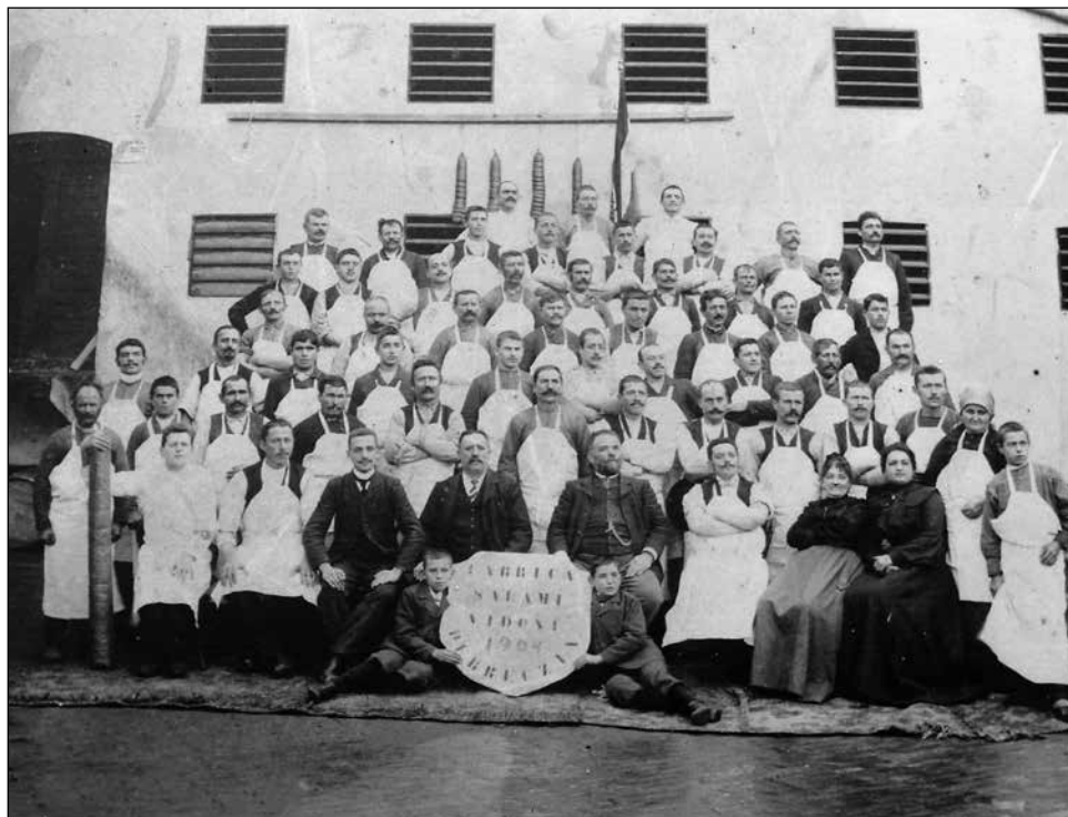
Figura 1 I proprietari e i lavoratori dello stabilimento Vidoni, Debrecen (1904) 94
