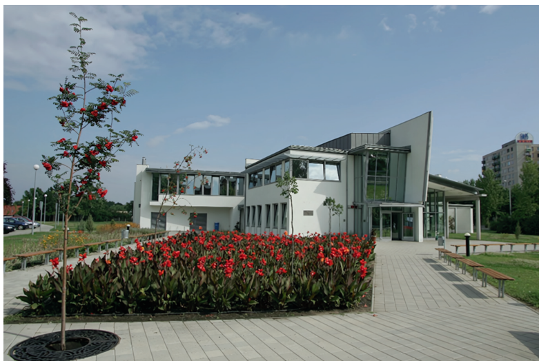
5. kép. A Táj- és Vidékfejlesztési Központ épülete
