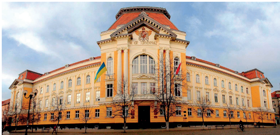
1. kép. A beregszászi Rákóczi Főiskola főépülete, az egykori törvényszékház
