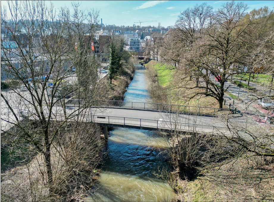
Abb. Nr. 3: Bácsalmás-Brücke über die Murr in Backnang . Foto: Christian Nathan
