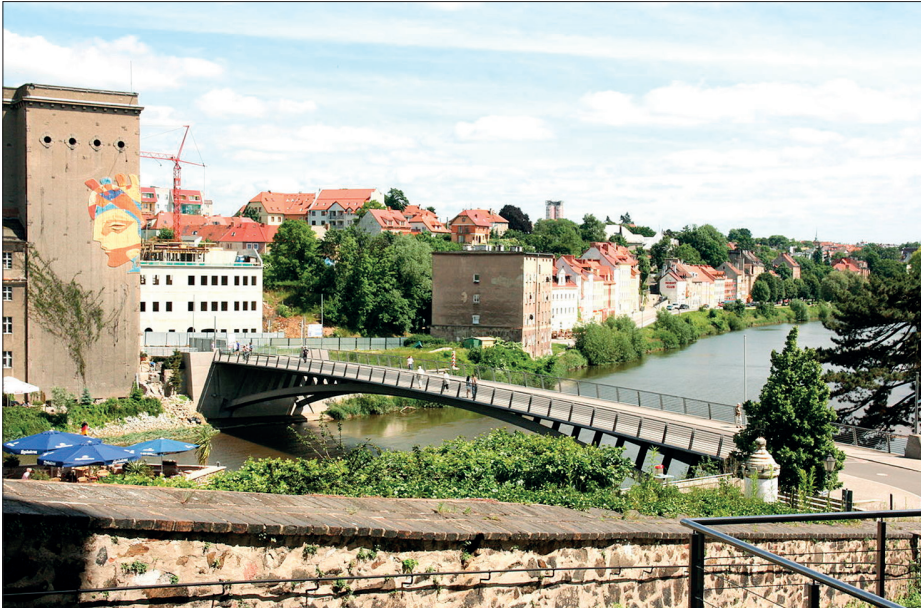
Abb. Nr. 6: Altstadtbrücke Görlitz-Zgorzelec, von der polnischen Seite aus gesehen. Foto: Frank Vincentz, Wikimedia commons
