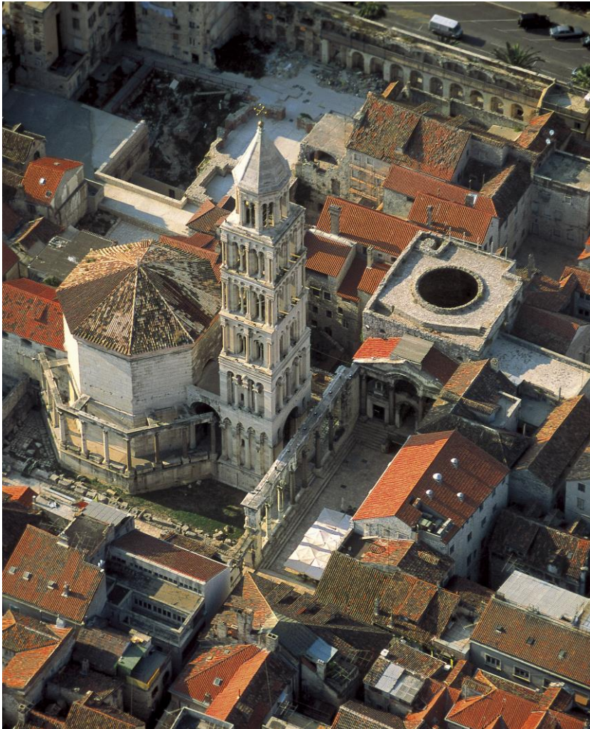
Abb. 2. Peristyl, Mausoleum, Vestibül und der mittlere Part der kaiserlichen Wohnung des Diokletianpalastes, Photo. I. Pervan
