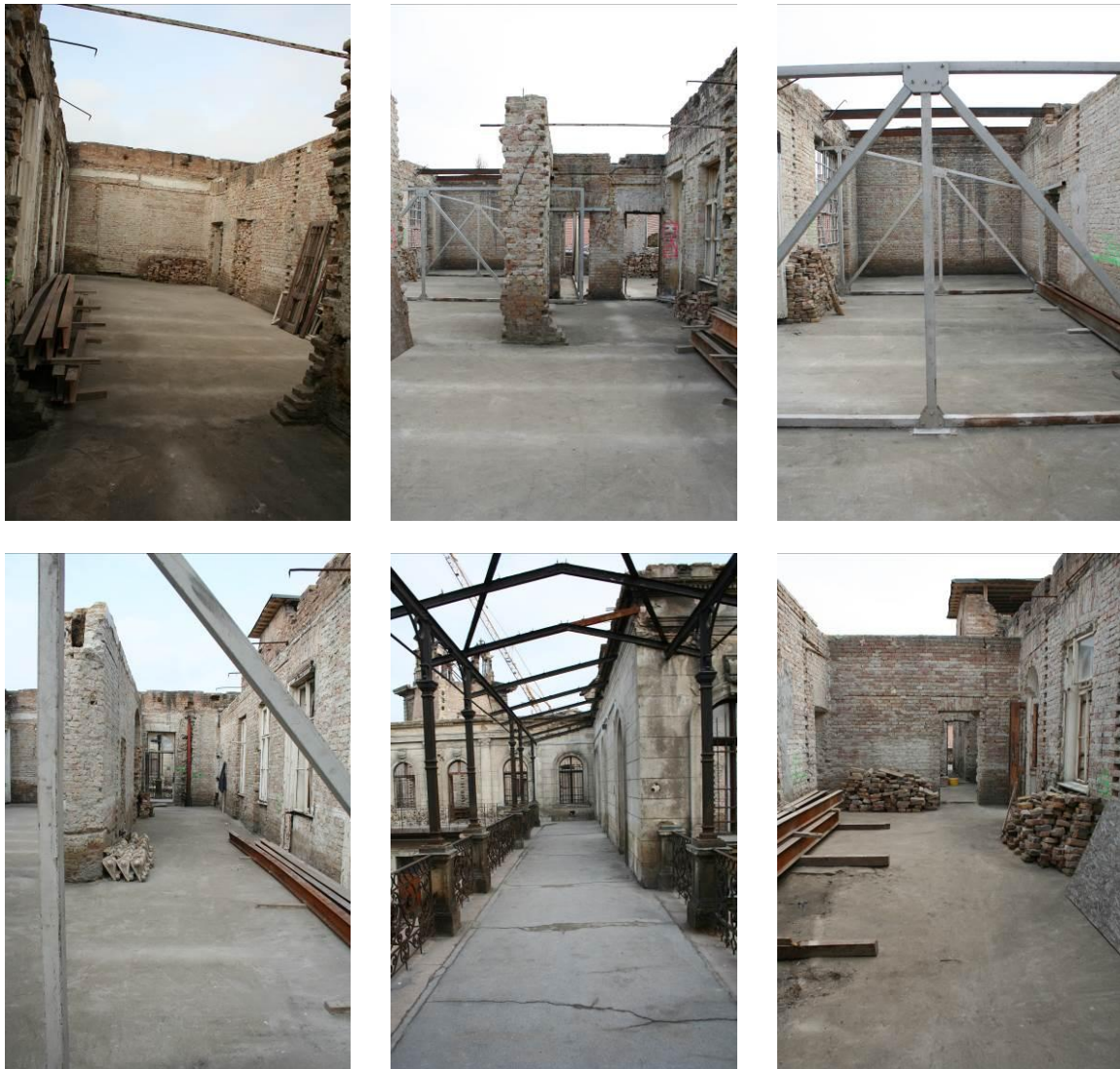
5. ábra: Az Andrassy útra merőleges belső szárny és előtte a függőfolyosó belülről
