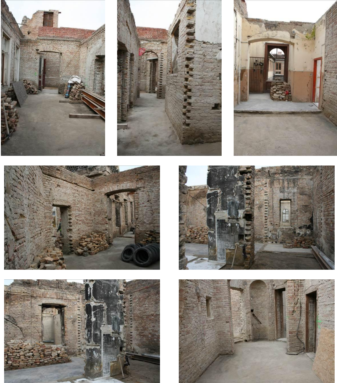
6. ábra: A Köröndi szárny belülről
