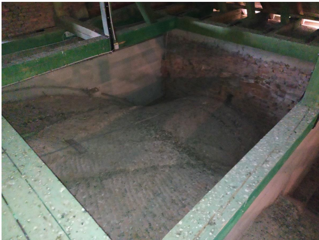
5. ábra: A templom falában található gerendafészkek /forrás: A szerző saját fényképe/
