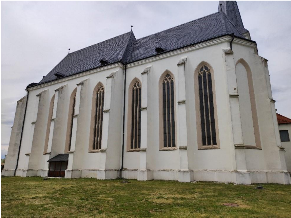
3. ábra: A templom déli homlokzatának támpillérei és mérműves gótikus ablakai /forrás: A szerző saját fényképe/
