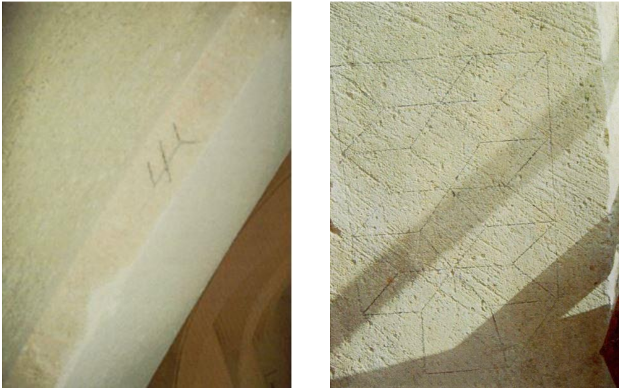
6.-7. ábra: A baloldali képen a diadalíven talált kőfaragó szimbólum, a jobb oldali képen a bekarcolt boltozati rajz szerepel [16]
