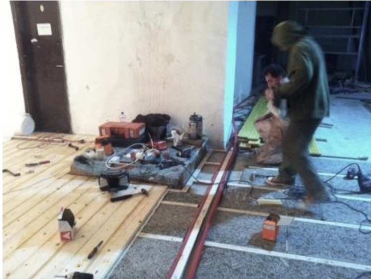
5. kép. Szabadkikötő átalakítási munkák, burkolás (forrás: Szuhay Márton)
