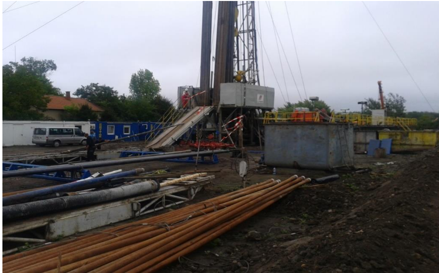
3. ábra: A visszasajtoló kút fúrási munkái
