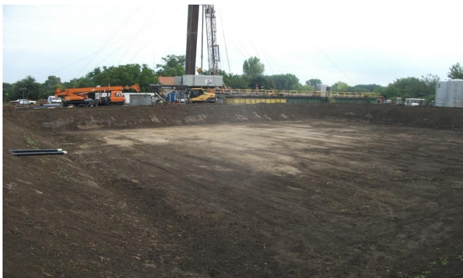
4. ábra: A tározó építése, elkészült földmű
