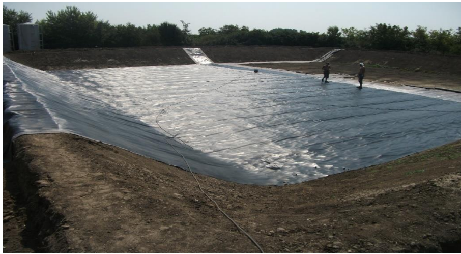
5. ábra: A szigetelés elkészítése (fólia vastagsága: 1,5 mm)
